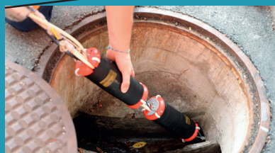
Zugang durch Sickerleitung
